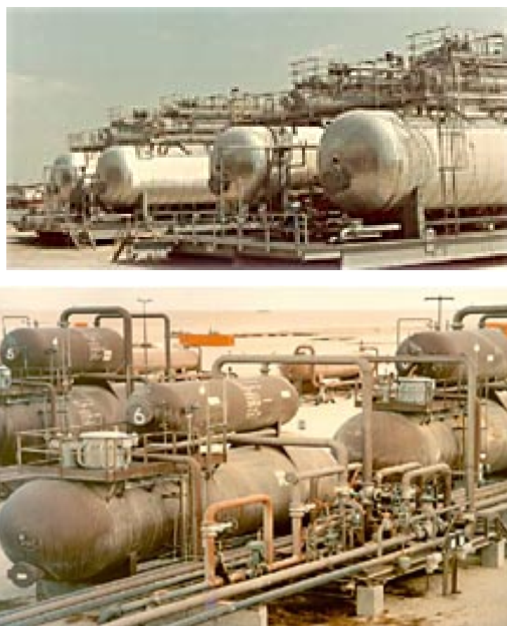
Сл. 2.6. Изглед на постројките за десоленизација/дехидратација на суровата нафта.
